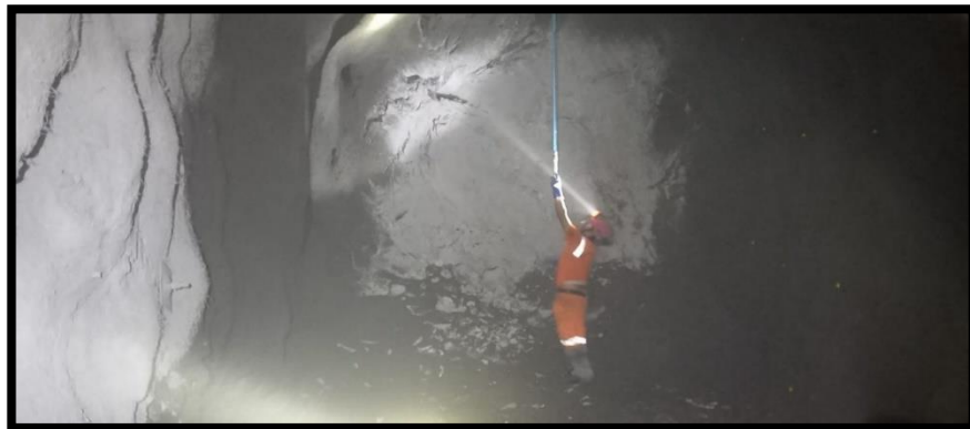
Figura 1: Instalación de los calibradores: se evidencia la instalación de los calibradores del operador de robot en el XC200 NV23.
