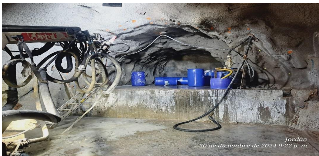
Figura 1: Abastecimiento de aditivo acelerante fragua: se evidencia al robot estacionado para abastecer aditivo acelerante en el cámara de aditivo NV 20
