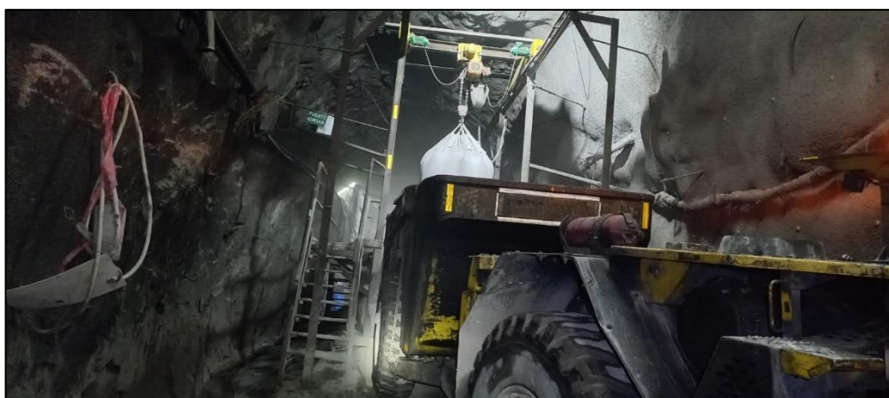
Figura 1: descarga de cemento en big bag de dumper
