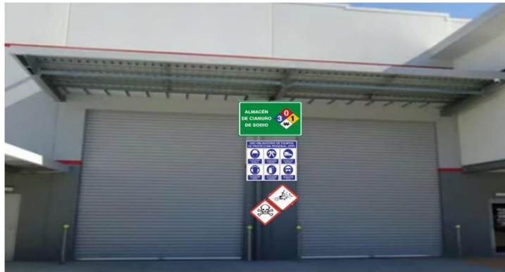
Imagen 3: Instalaciones almacén – Señalización
