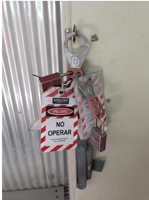
Imagen 1. Ejemplo de bloqueo personal uso de candado rojo y tarjeta de bloqueo.
